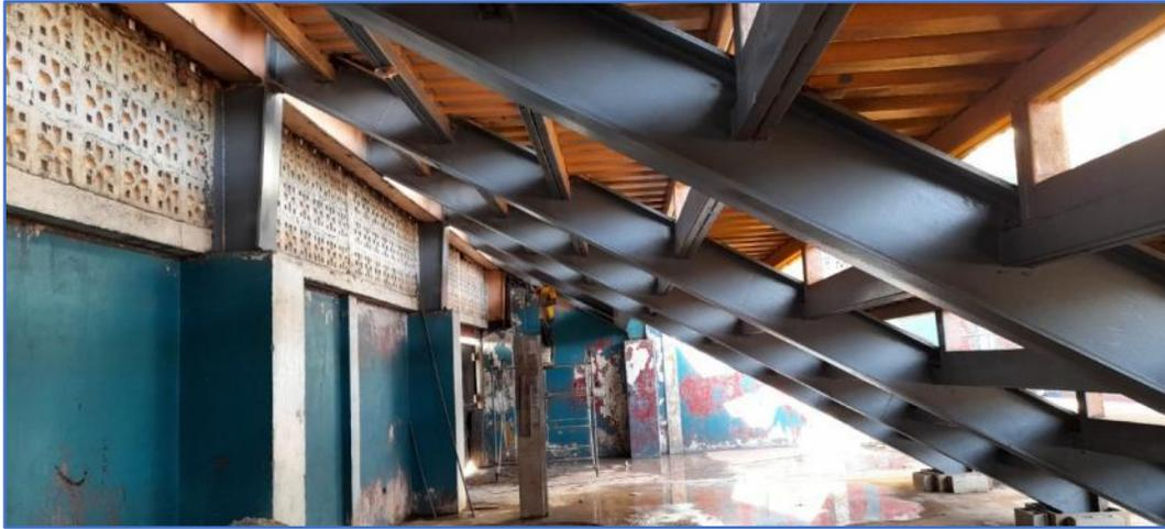
Foto mostrando las vigas metálicas que sostienen las graderías, con la aplicación de la primer mano de pintura anticorrosiva.
