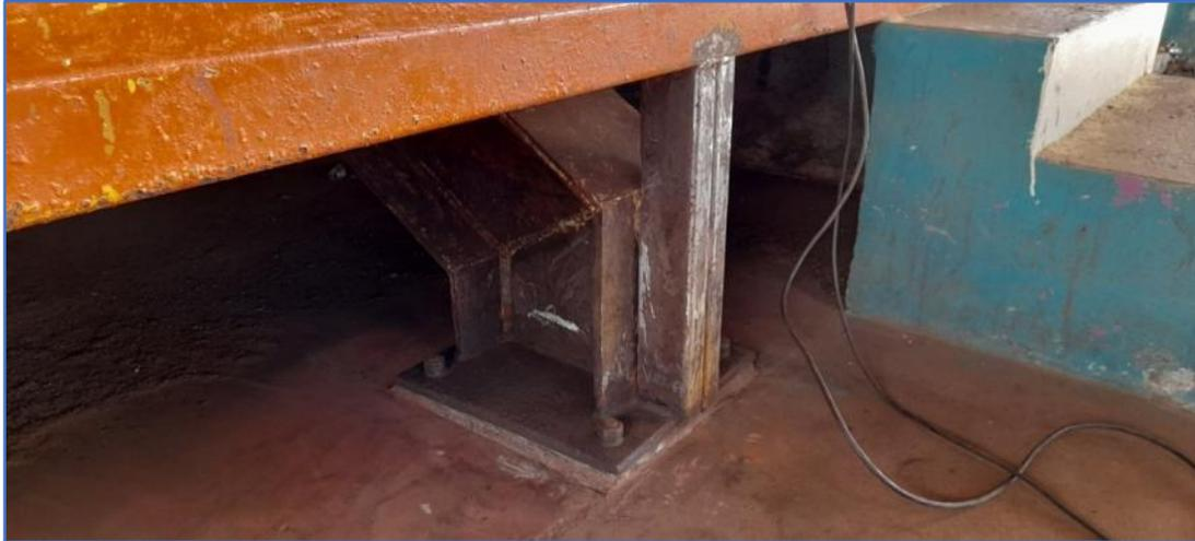
Otra platina y pernos limpio se observan elementos en buen estado.
