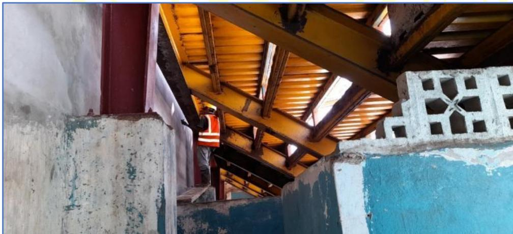
Aquí apreciamos la ejecución de la limpieza de los elementos metálicos debajo de las graderías existentes.
