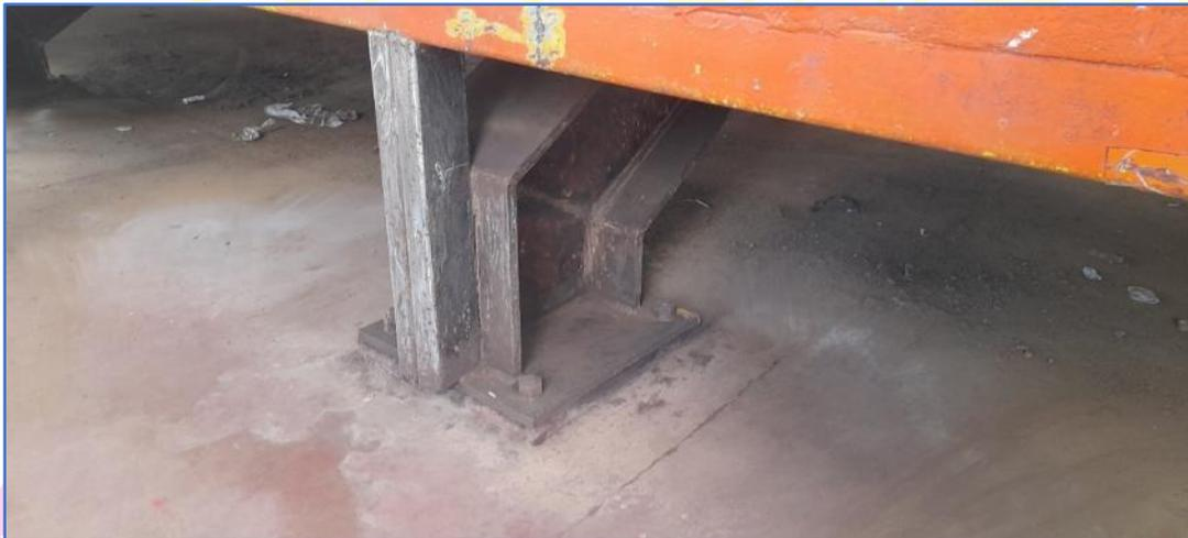
Platinas, pernos de anclajes y pedestal metálicos limpios.
